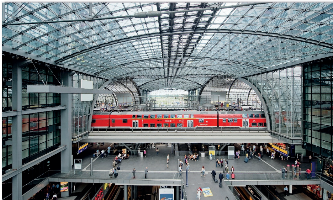
Рисунок 2. Вокзал Берлина на станции Берлин - Главный
